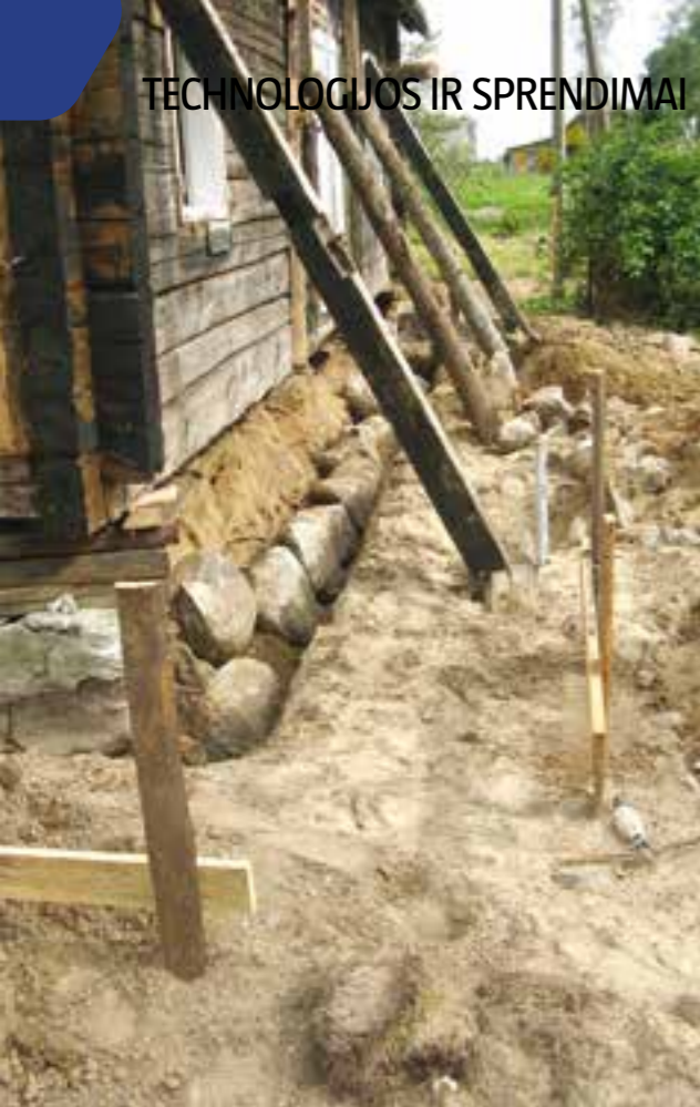
Rąstiniai namai dažniausiai statyti ant negiliai į žemę įleistų pamatų. Šiandien renovuojant pastatą reikia juos sustiprinti ir net apšiltinti.
