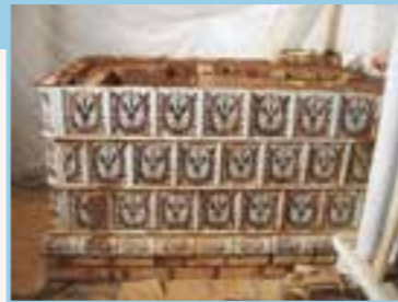
Biržų pilies XVII a. krosnies rekonstrukcija, naudojant vietinę archeologinę medžiagą (šiuo metu krašto muziejus „Sėla“). Projekto aut. D. Strazdas, koklius pagamino krosnį pastatė VšĮ „Vilniaus puodžių cechas“, vad. D. Strazdas, 2006 m. Foto A. Stellaccio.
