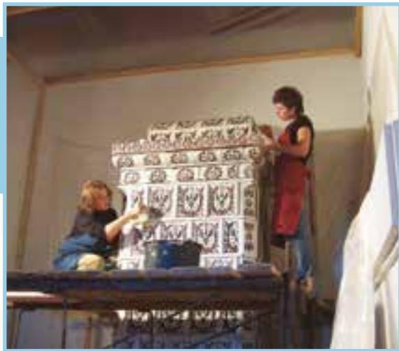
Biržų pilies XVII a. krosnies rekonstrukcija, naudojant vietinę archeologinę medžiagą (šiuo metu krašto muziejus „Sėla“). Projekto aut. D. Strazdas, koklius pagamino krosnį pastatė VšĮ „Vilniaus puodžių cechas“, vad. D. Strazdas, 2006 m. Foto A. Stellaccio.
