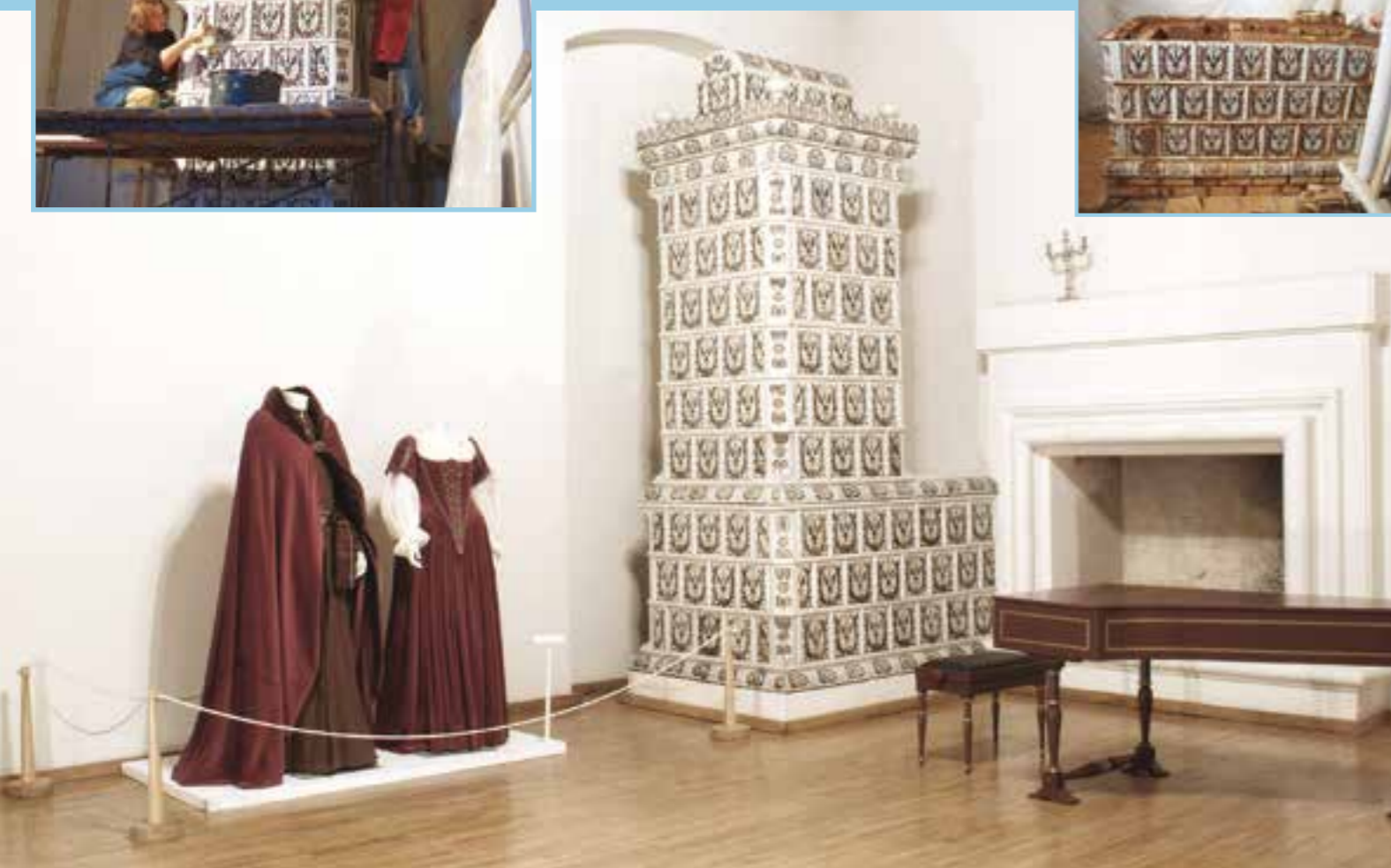
Biržų pilies XVII a. krosnies rekonstrukcija, naudojant vietinę archeologinę medžiagą (šiuo metu krašto muziejus „Sėla“). Projekto aut. D. Strazdas, koklius pagamino krosnį pastatė VšĮ „Vilniaus puodžių cechas“, vad. D. Strazdas, 2006 m. Foto A. Stellaccio.
